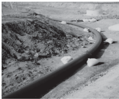
曲げ配管事例①
